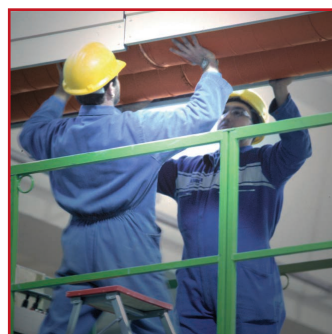
Staff tecnico di montaggio Installation team
